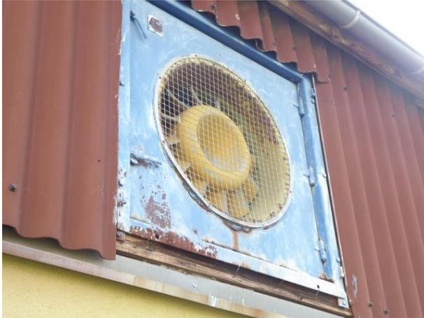
Abb. 7: Vergitterter Ventilator und mit wellplattenverkleideter Außenwand von Gebäude A.
