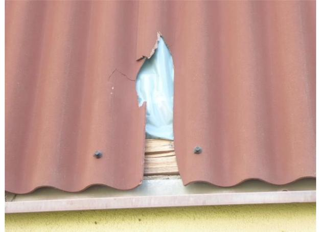
Abb. 8: Schadhafte Wellplatten mit Lücken an verkleideter Außenwand von Gebäude A.
