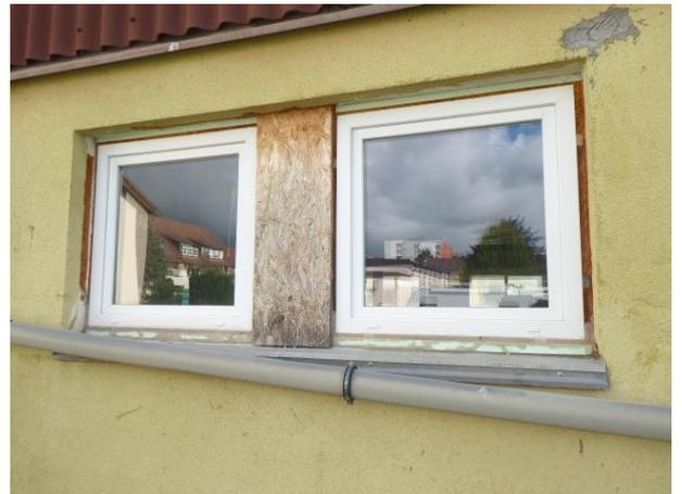
Abb. 10: Neu eingebaute Fenster des Gebäudes A ohne Nischen oder Spalten.
