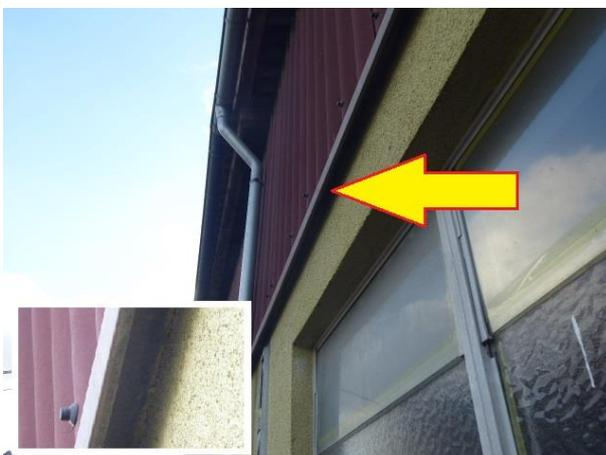
Abb. 5: Breiter Übergangsspalt zwischen Wellplattenverkleidung und Wand von Gebäude A.
