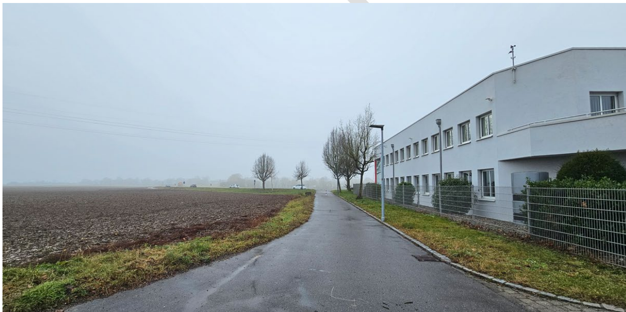
Abb.: Impressionen aus der Bestandssituation (2025)
