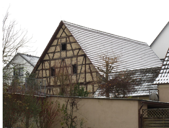
Foto 6: Neckarstraße 14 (östlicher Giebel)
