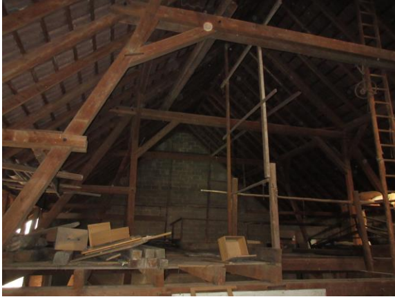
Foto 1: Kirchstraße 10 (südlicher Teil der Scheune)
