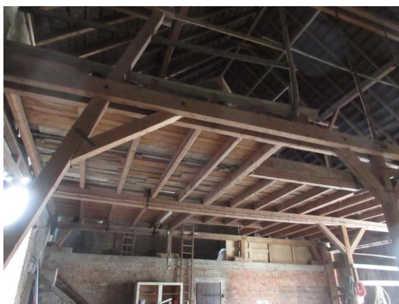
Foto 11: Kirchstraße 10 (Blick in die Scheune)
